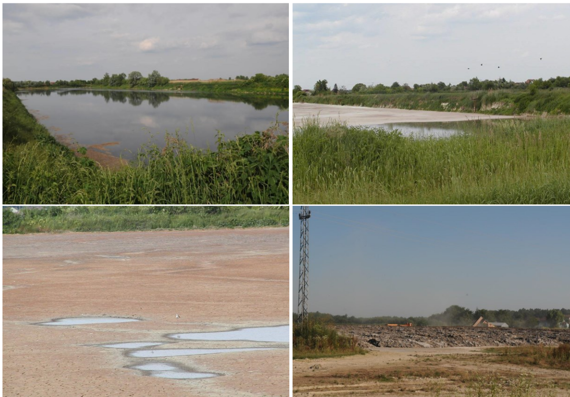
Slika 7. Taložnica s visokom razinom vode u proljeće (gore lijevo); djelomično prazna početkom ljeta (gore desno); lokve zaostale nakon pražnjenja taložnice krajem ljeta (dolje lijevo); deponiranje mulja u blizini taložnice (dolje desno) (preuzeto iz Grlica i Grlica, 2013; Grlica i Grlica, 2014)
